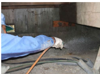
床下では、木部処理及び土壌に薬剤散布を行います。
